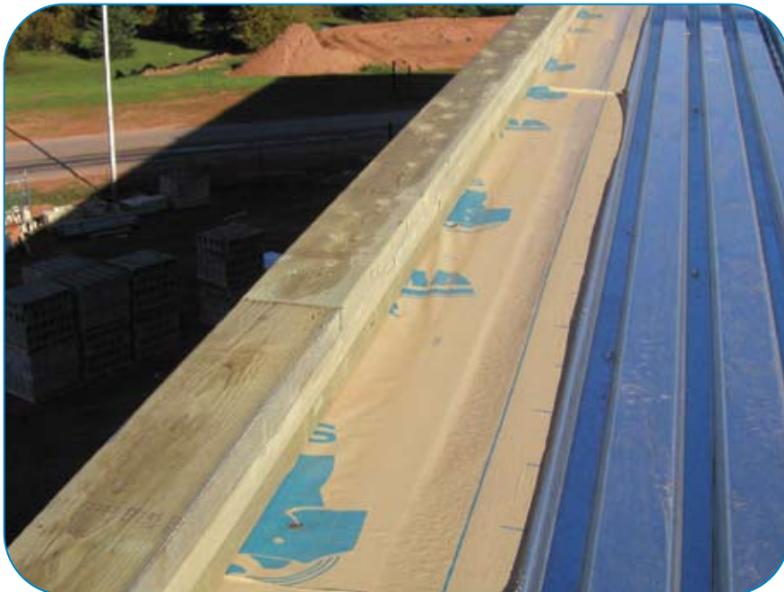
Afin d'assurer la continuité du pare-air et pare-vapeur, on peut simplifier la coordination des différents métiers sur le chantier par la spécification de l'installation d'un pare-air et pare-vapeur autocollant par le charpentier-menuisier, avant la construction du parapet.
